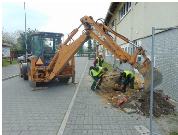
Przy pracach konieczne było użycie ciężkiego sprzętu
