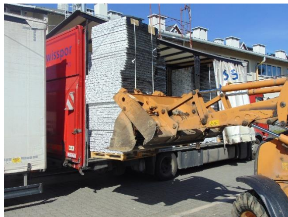
Wyładanie potrzebnego styropianu
