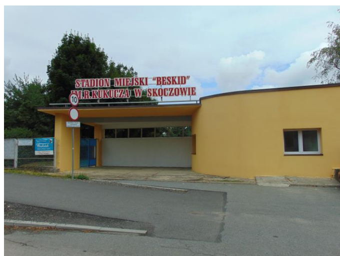
Wyremontowany budynek portierni na Stadionie Miejskim w Skoczowie
