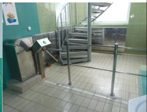
Bramka obrotowa przed wejściem na schody zjeżdżalni
